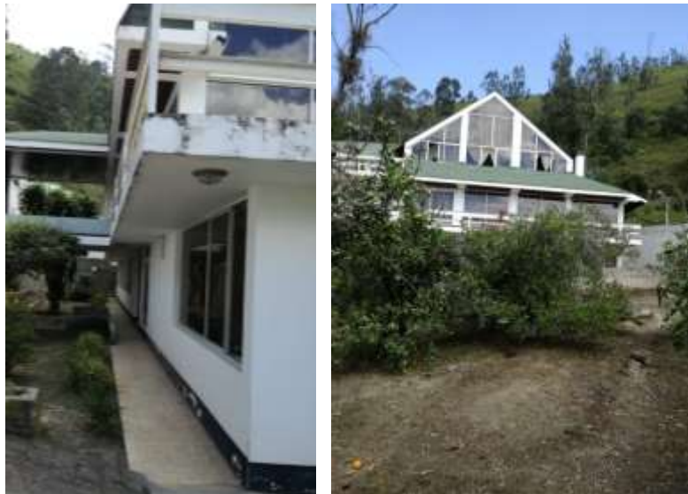
Figura 65. Estado actual de piso exterior.
