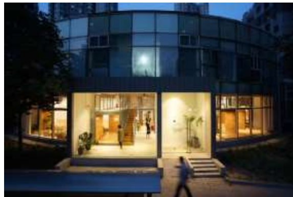
Figura 29. Fachada frontal – ingreso principal.
