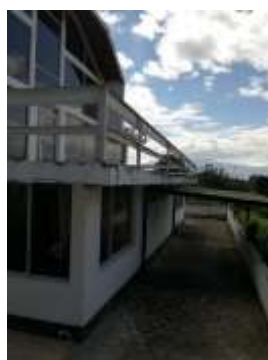
Figura 2. Vista exterior de fachada lateral derecha.
