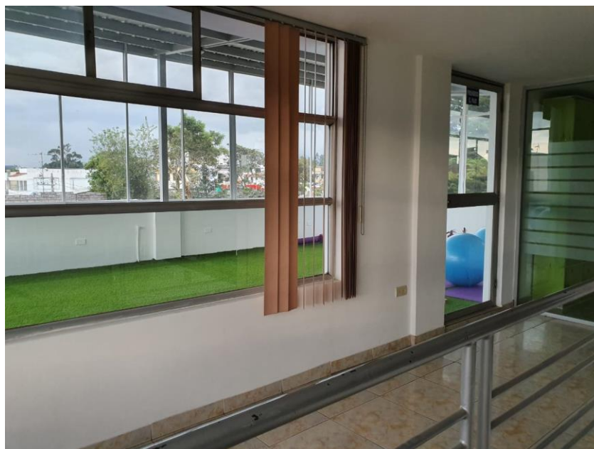
Figura 2. Terraza cubierta revestimiento de césped sintético
