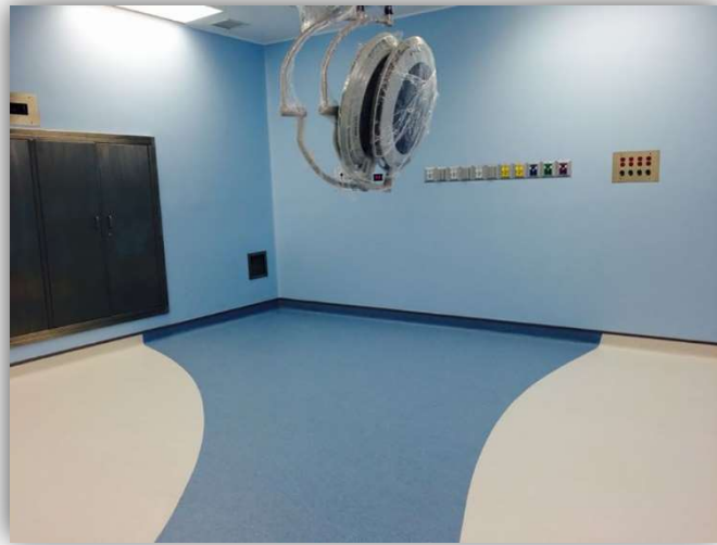
Figura 33: Ejemplo de Piso conductivo
