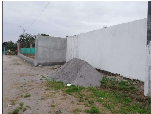
Cerramiento en hormigón armado, faltan acabados.
