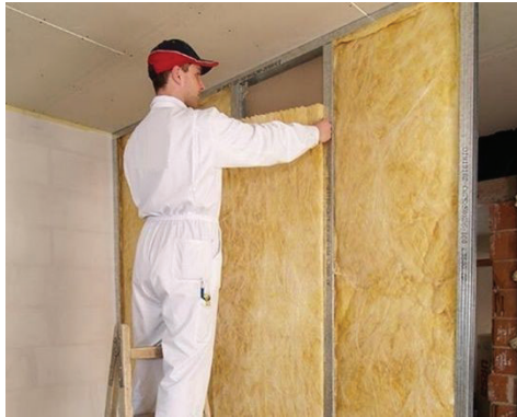
Figura 33: Instalación de aislamiento de fibra de vidrio. Tomado de (ACIMCO, s.f.)
