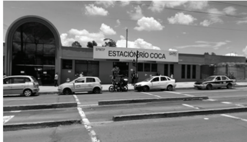
Figura 93. Estación Intermodal de la Av. Río Coca
