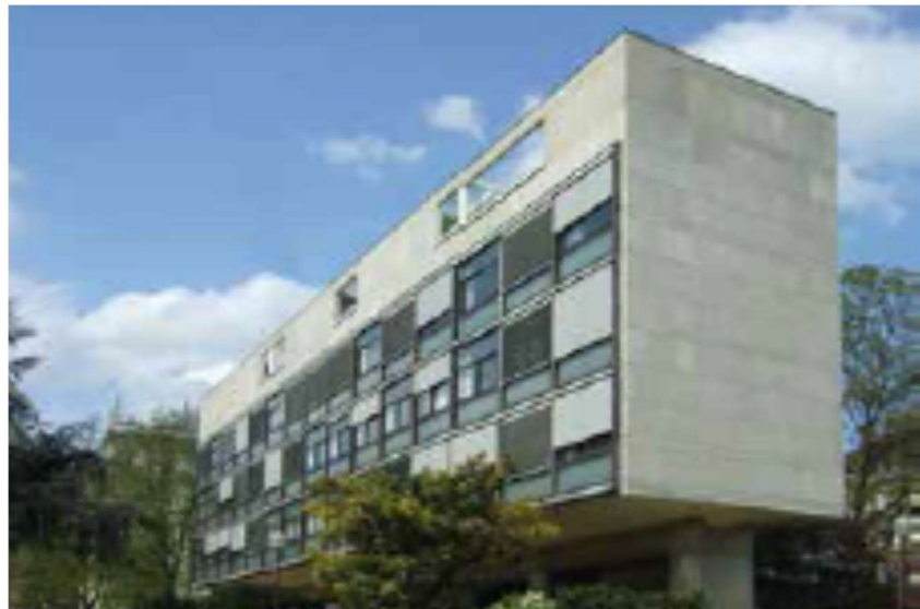
Fachada Sur. Acristalamiento continuo de las habitaciones de los estudiantes con vistas a las zonas deportivas.
