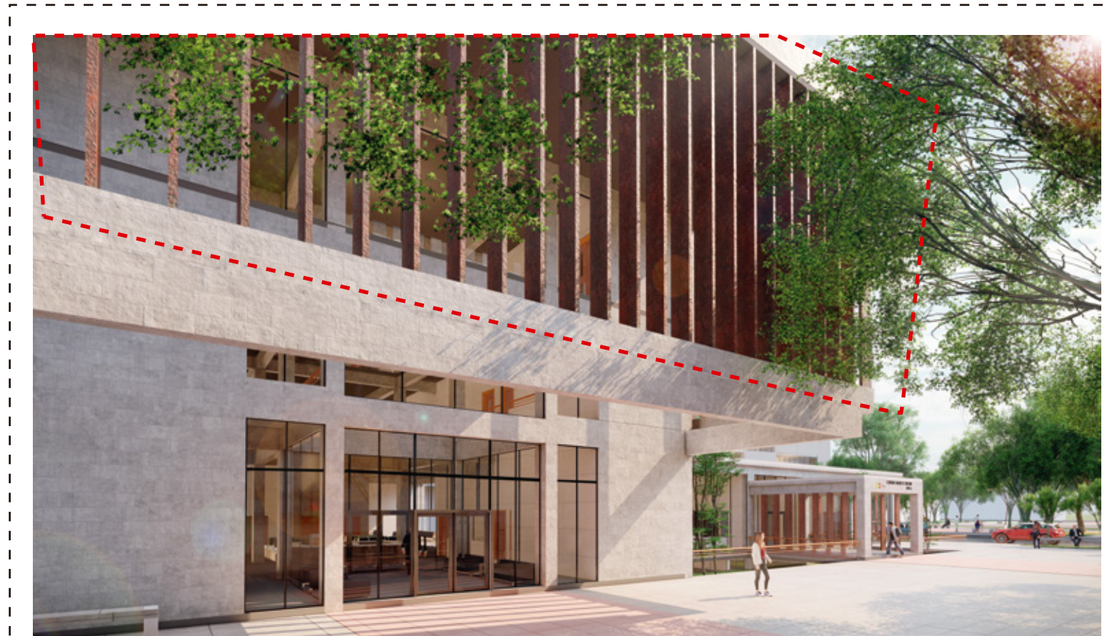
BLOQUE PRINCIPAL CON CORTASOLES FIJOS
