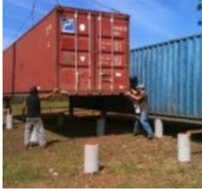
Figura 39. Mojones de Hormigón.
