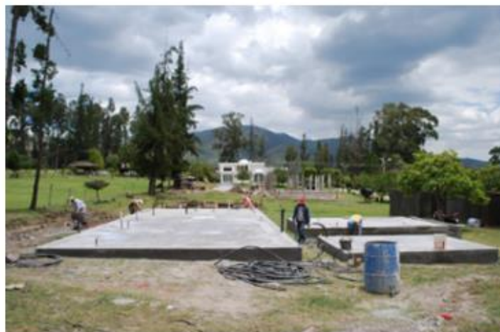
Figura 26. Plataformas de Hormigón.
