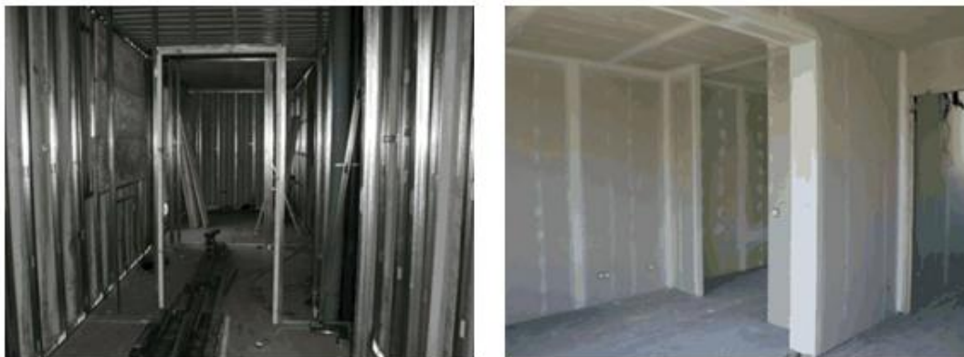
Figura 54. Paredes internas de Gypsum.
