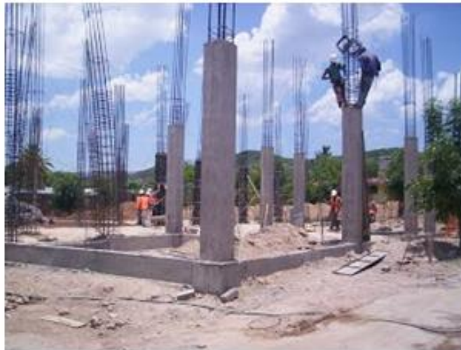
Figura 48. Columnas de Hormigón Armado.
