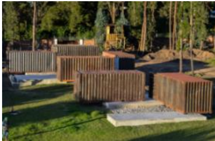
Figura 29. Contenedores instalados en bases.
