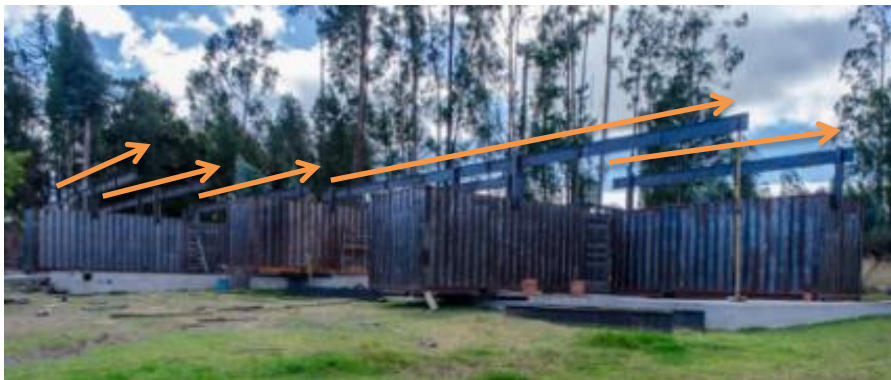
Figura 32. Vinculación entre contenedores por medio de vigas.
