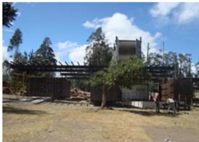
Figura 34. Vinculación entre contenedores por medio de vigas.
