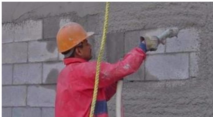
Figura 56. Enlucido de mampostería de bloque.
