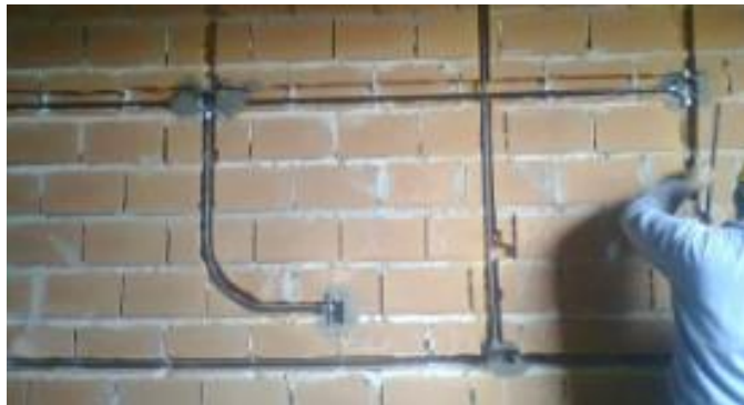
Figura 58. Instalaciones Eléctricas vivienda convencional.
