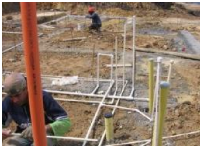
Figura 59. Instalaciones Sanitarias vivienda convencional.
