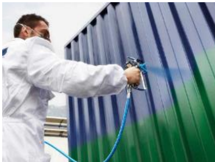
Figura 114: Capa de pintura anticorrosiva.
