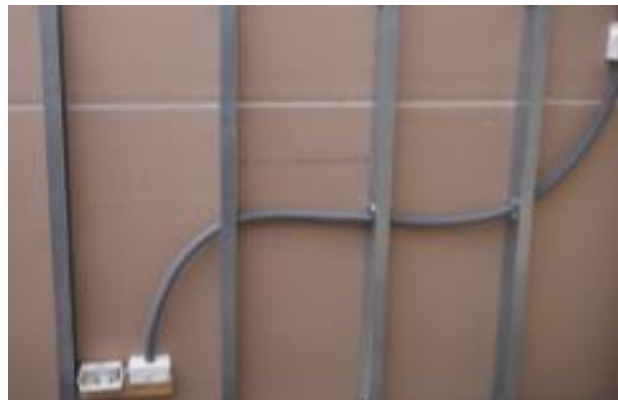
Figura 108: Circuito eléctrico en tubería flexible.
