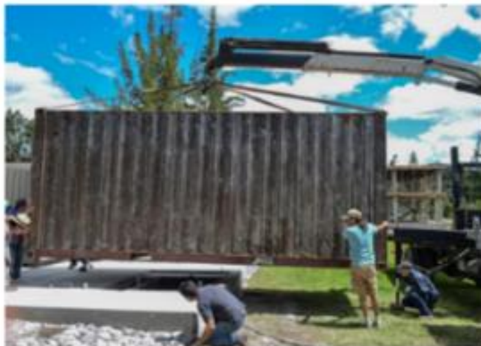
Figura 28. Montaje de contenedores.
