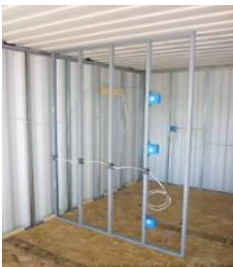
Figura 102: Perfilería en paredes interiores.
