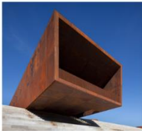
Figura 44. Construcción con acero COR-TEN.
