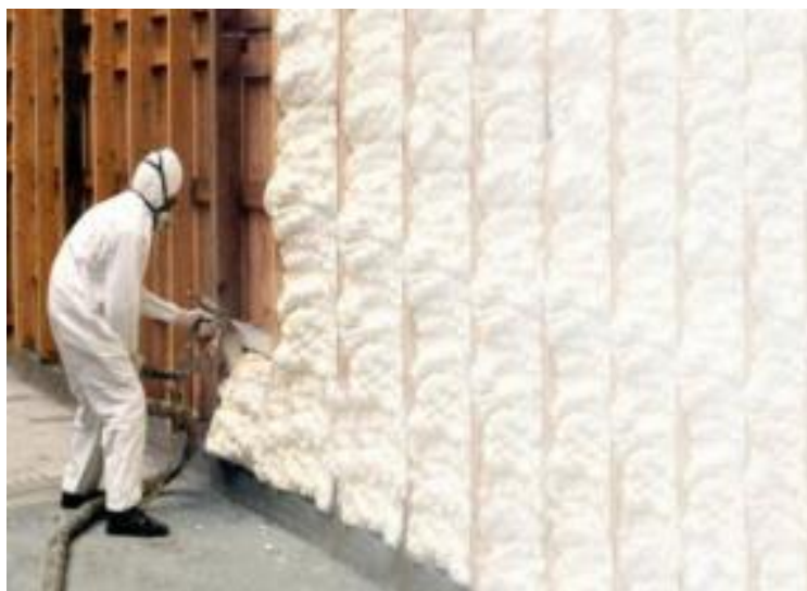
Figura 113: Aplicación de la espuma de poliuretano.
