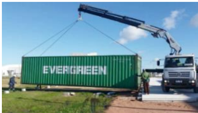
Figura 96. Montaje mediante grúa.
