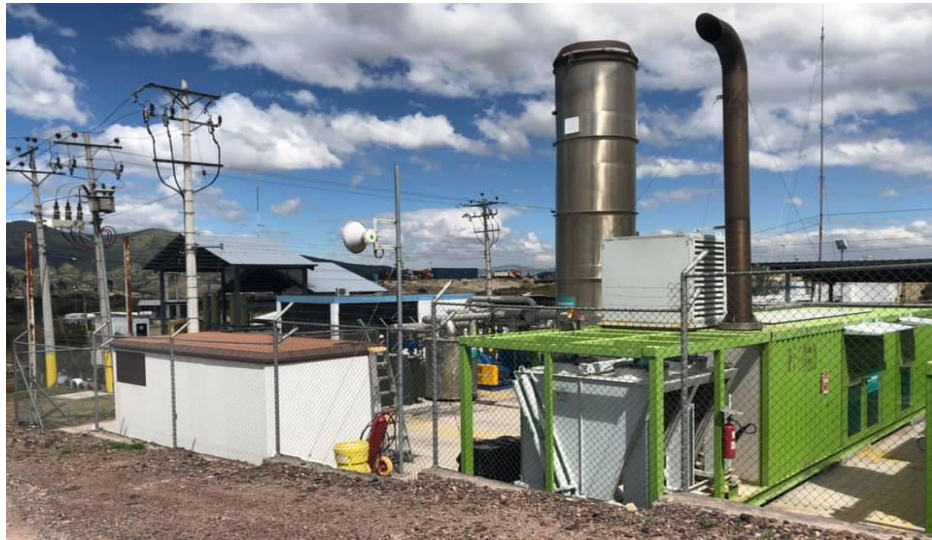
Figura 3. Planta de generación de energía a través de la captación de biogás.
