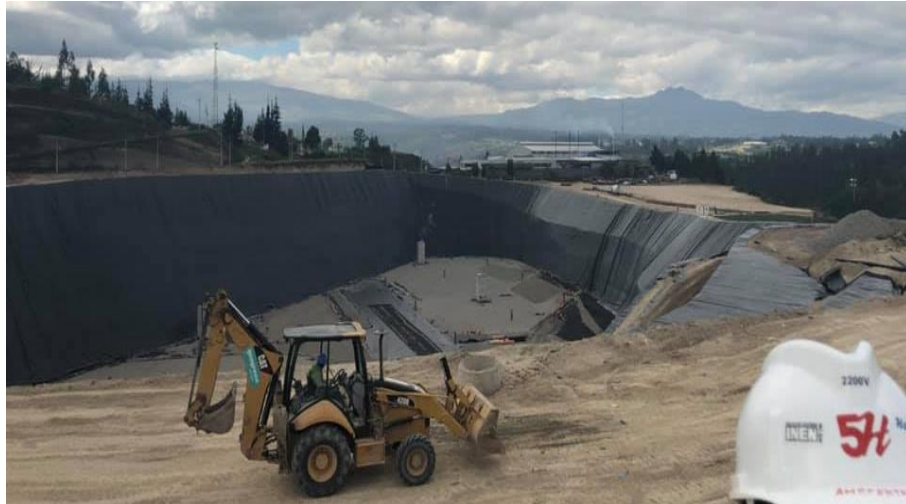
Figura 4. Cubeto del Relleno Sanitario El Inga.
