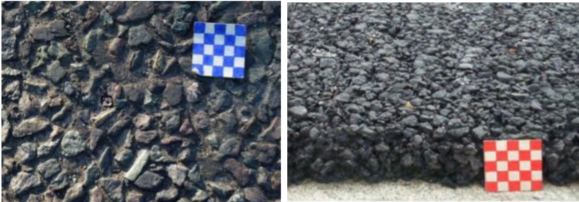
Figura 2. Calle de asfalto denso en azul y Calle de asfalto poroso en rojo
