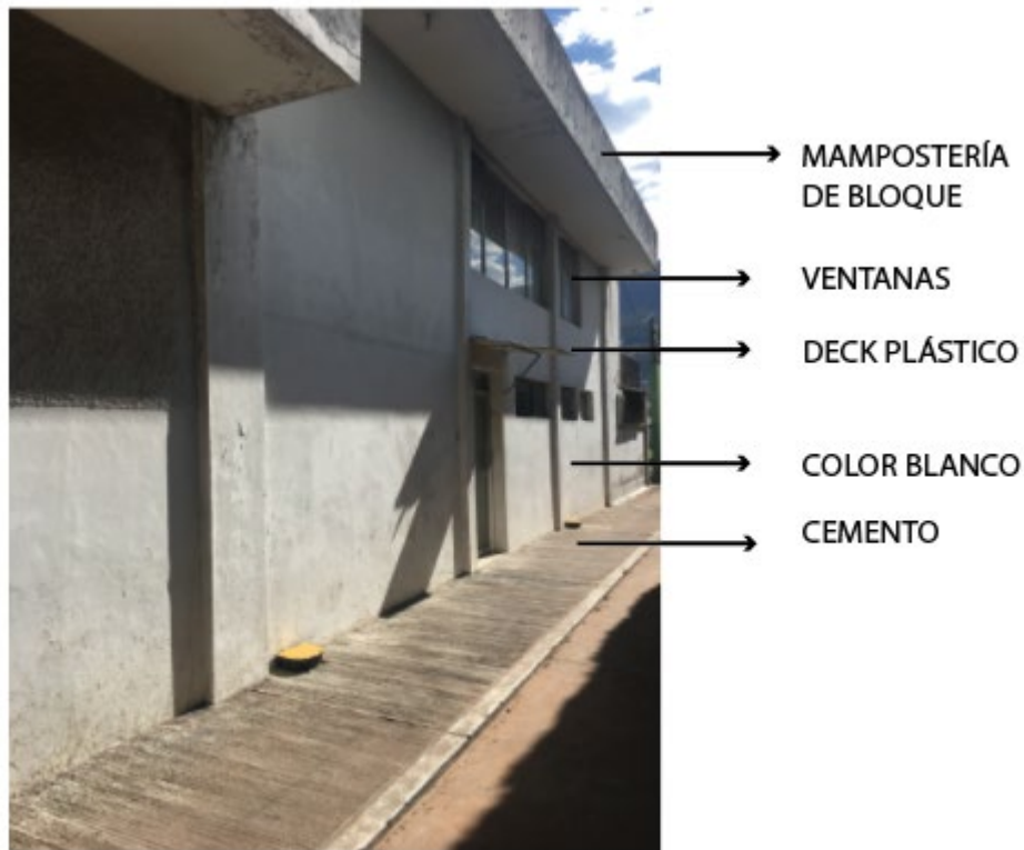
Figura 61. Ilustración 1 Análisis de la parte externa en el interior del Club La
