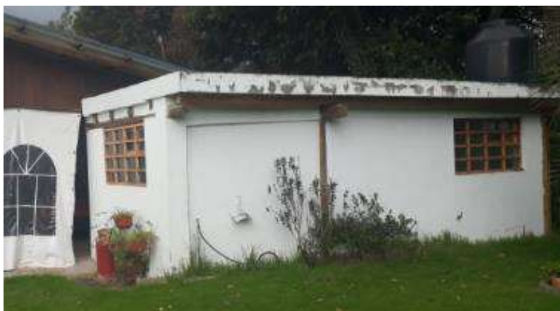
Figura 70. Vista exterior de los SS. HH.
