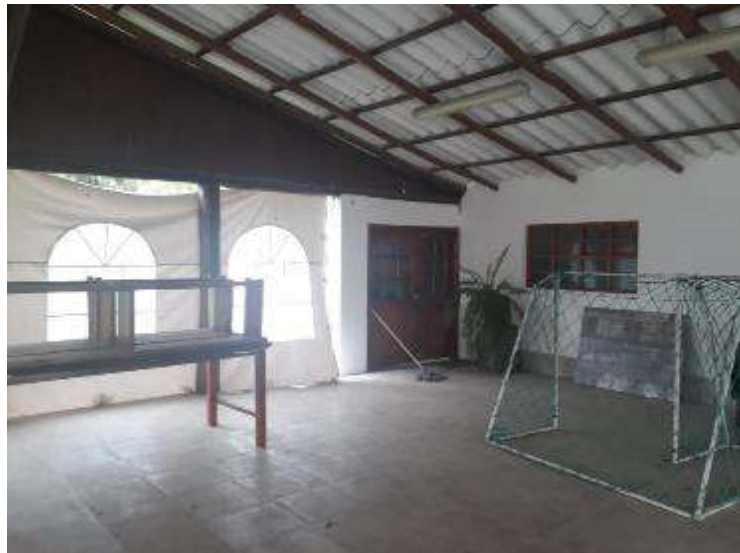
Figura 68. Ingreso al área de cocina
