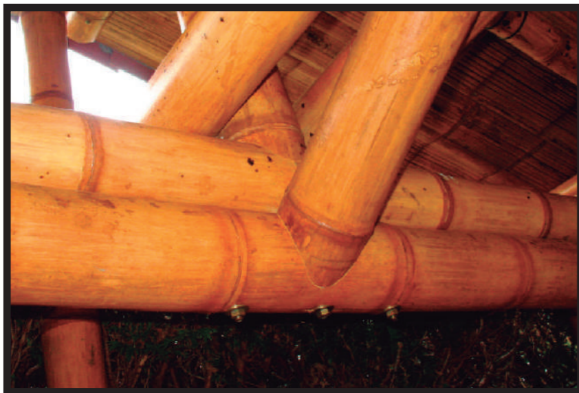
DISEÑO MODELO ENSAMBLAJE TIPO "BOCA DE PESCADO"
