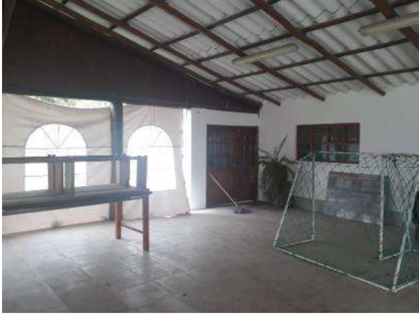
Figura 66. Ingreso al área de cocina
