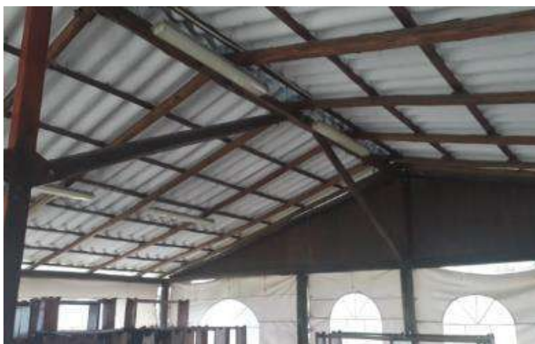
Figura 80. Vista de la cubierta desde su interior.
