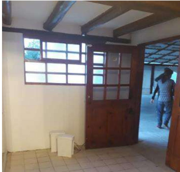
Figura 71. Ingreso principal mixto hacia los SS. HH.
