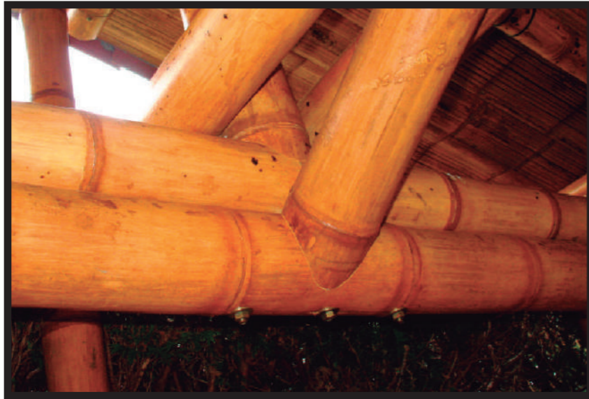
DISEÑO MODELO ENSAMBLAJE TIPO "BOCA DE PESCADO"
