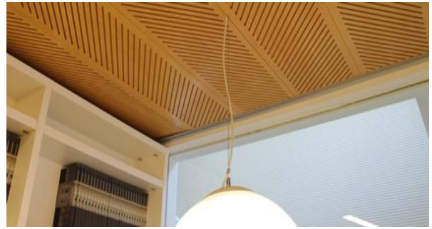
Figura 50 Tumbado Acústico Madera Adaptada de SpigoGroup, 2016.
