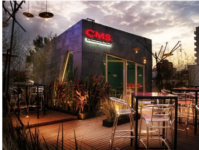
Figura 59 Fachada Principal Exterior
