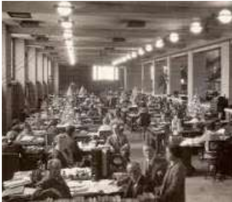
Figura 15. Interior del edificio.
