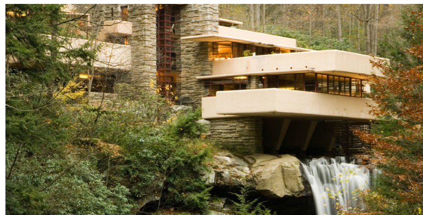
Figura 91. Casa de la Cascada de F. L. Wright. Tomado de Google Imágenes, s.f.
