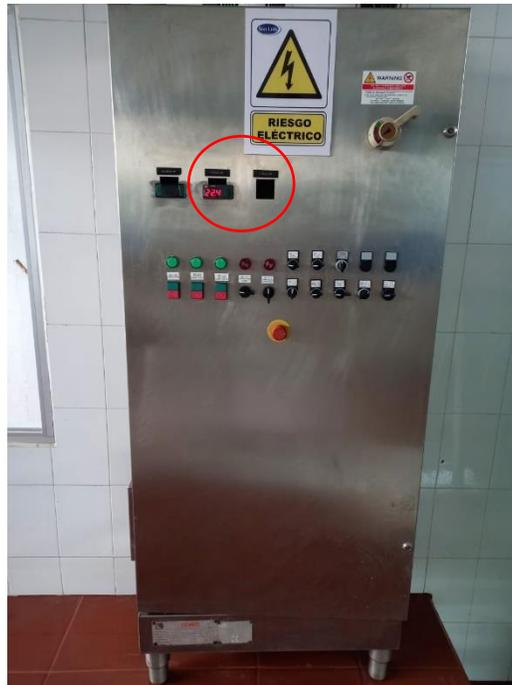
*Figura 66.* Tablero de control de temperaturas.
