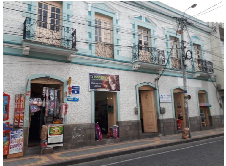
Figura 11. Fachada de la edificación
