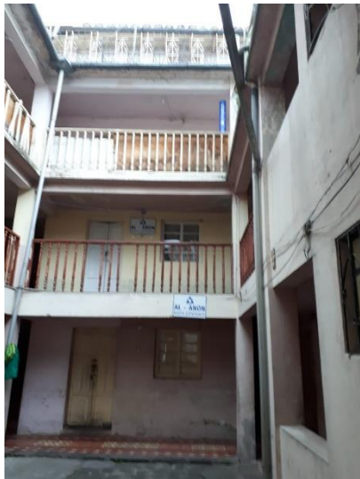
Figura 15. Patio central y pasillos.
