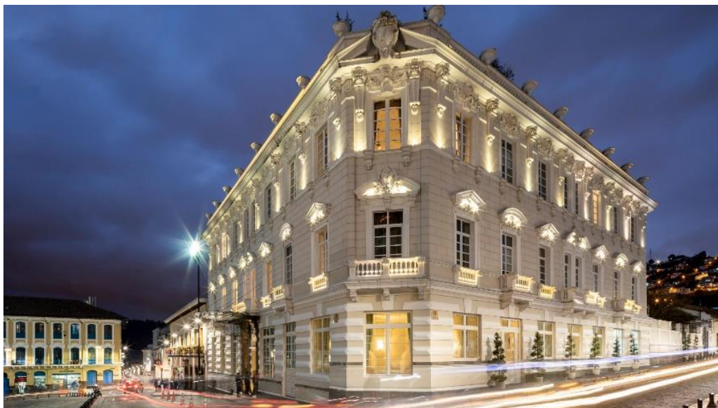
Figura 31. Exterior Casa Gangotena
