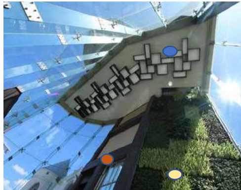
Figura94: Imagen interior del lobby
