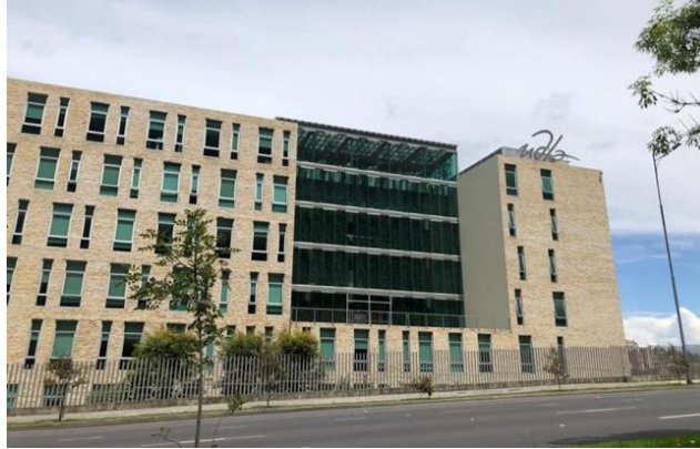
Figura 60. Edificación Universidad de Las Américas, Sede Udlá Park.
