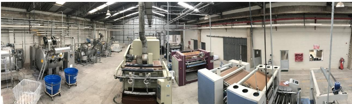
Figura 4. Vista panorámica de la planta - Sección Acabados.
