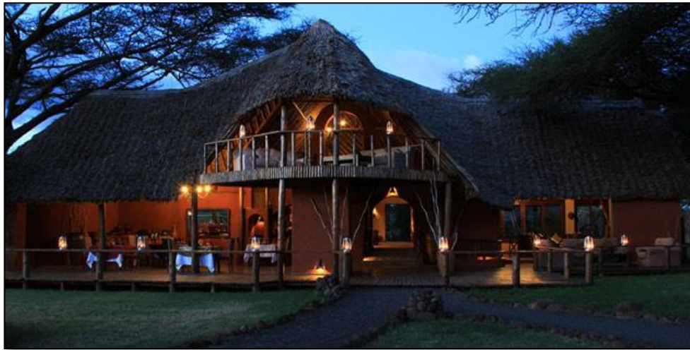
Figura 5. Fachada proyecto Tawi Lodge
