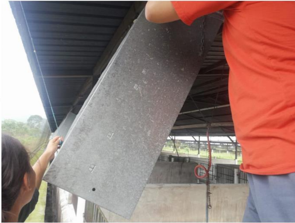
Figura 11. Colocación de ventilador
