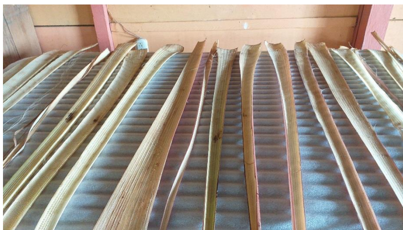
Figura 87. Tendido de fibra.
