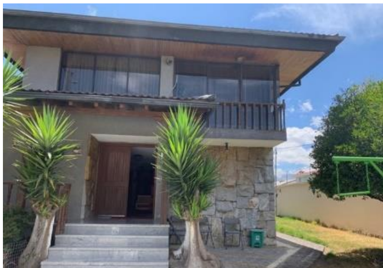
Figura 87. Exterior de la edificación.
