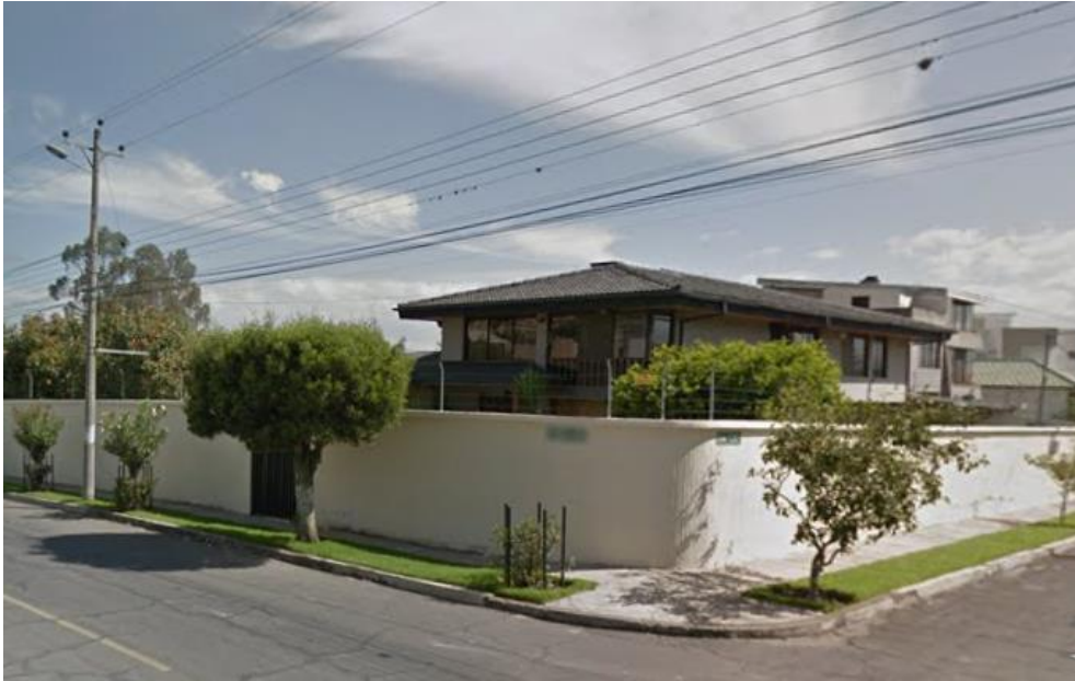
Figura 1. Exterior de la edificación.
