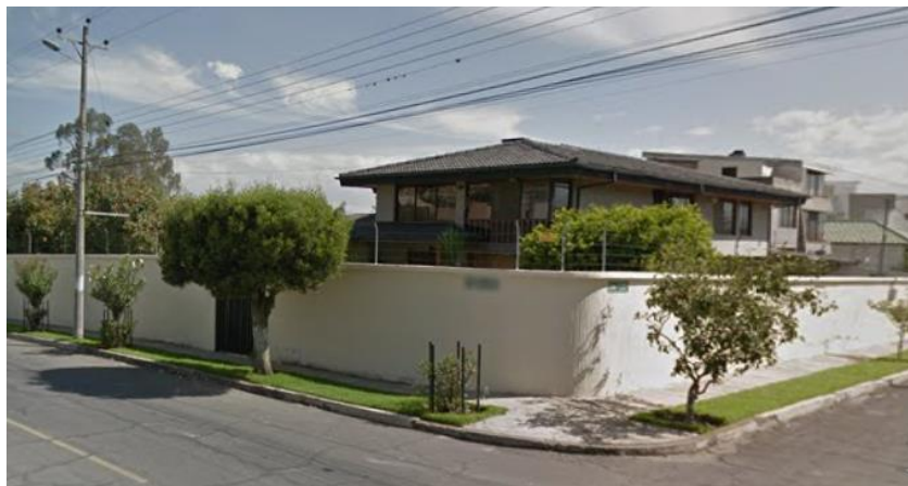
Figura 85. Exterior de la edificación.
