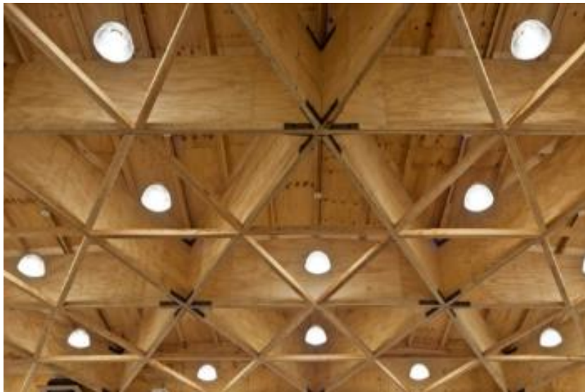
Figura 48. Cubierta de espacio interior
