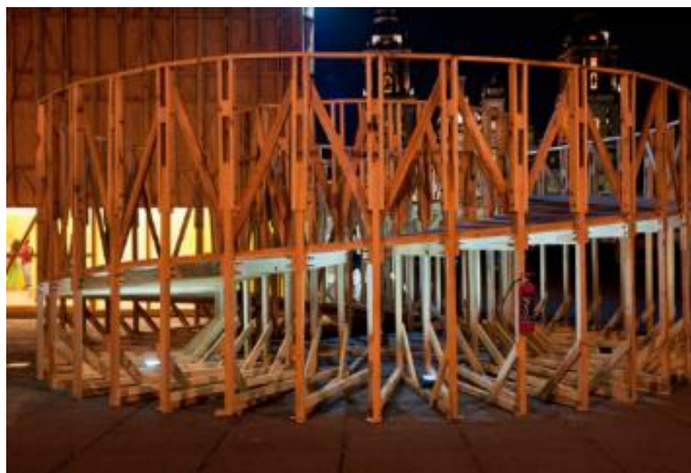
Figura 47. Estructura pabellón Tomado de (Plataforma Arquitectura,2014)
