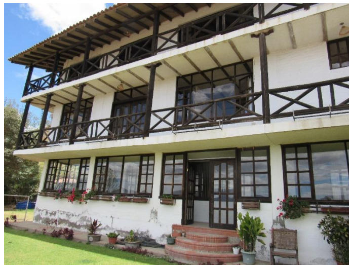
Figura 10. Fachada lateral izquierda
