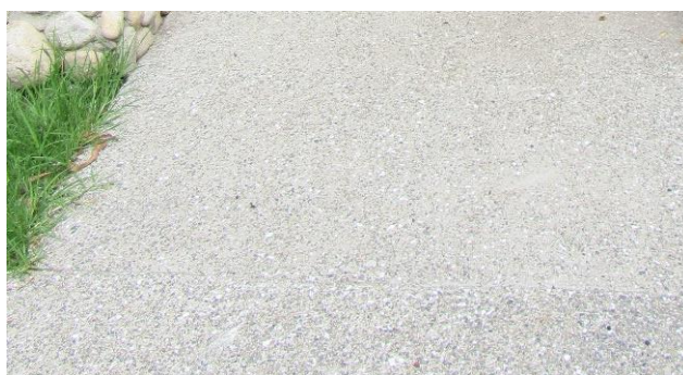
Figura 113. Piso exterior de piedra
