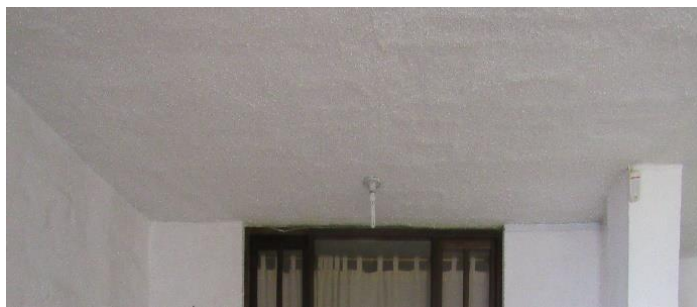
Figura 117. Cielo raso de concreto con textura
