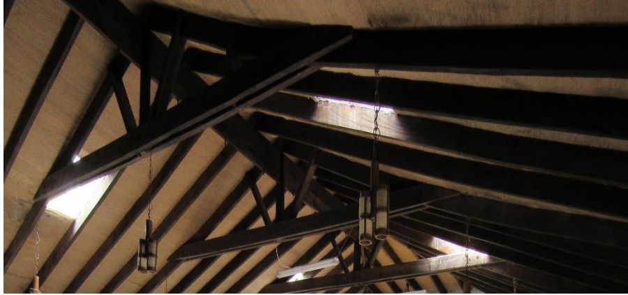
Figura 115. Cielo raso de estructura de madera cubierta con lona
