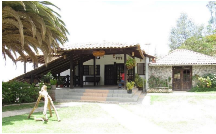
Figura 5. Ingreso de la edificación
