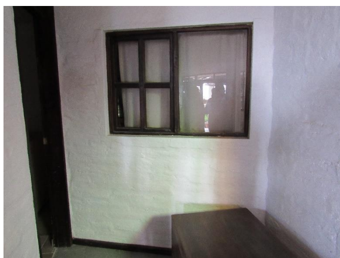
Figura 108. Paredes internas planta baja
