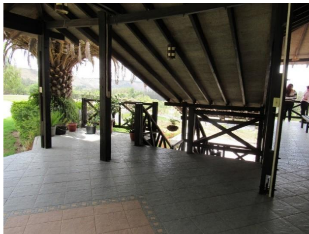
Figura 6. Escaleras internas de la edificación
