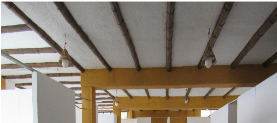
Figura 116. Cielo raso de concreto con diseño de madera sobrepuesta
