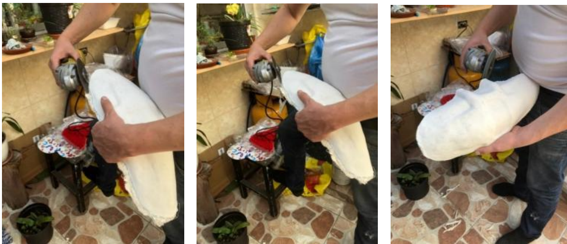
Figura 62 Corte de la pieza final con amoladora
