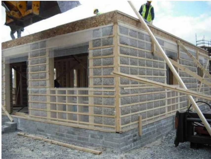
Figura 16 Construcción de una vivienda con cerramientos de hempcrete. Tomado de: Ochando, 2013.
