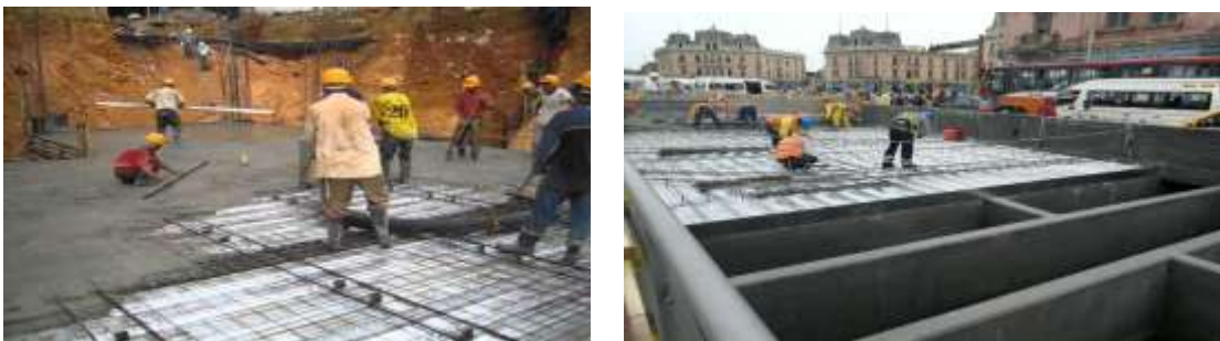
Figura 10 Losas con placas colaborantes Tomado de: (Nociones sobre el hormigón armado, s.f.)
