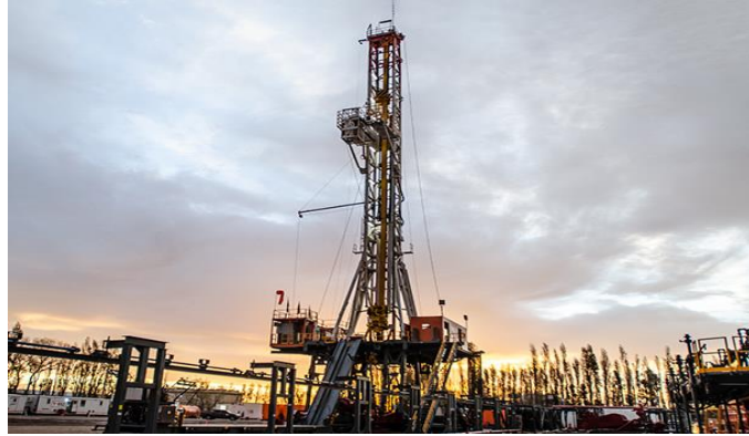
Figura 3. Torre de Perforación.
