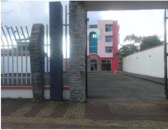
Ingreso desde la Av. Colombia
