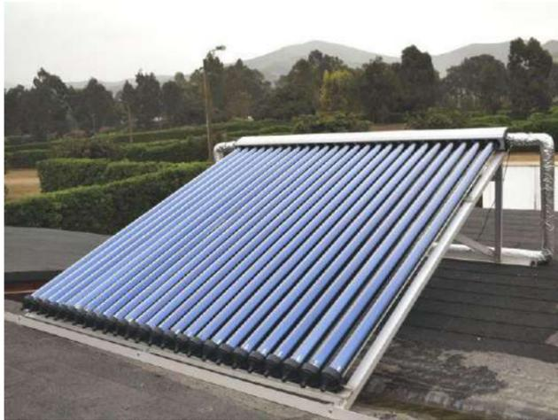
Figura 109. Captadores solares de media capacidad.
