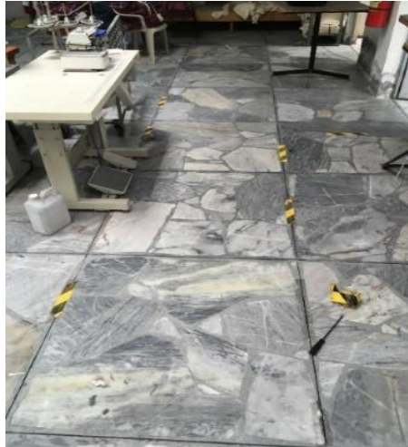
Figura 59. Retiro de señalética deteriorada.
