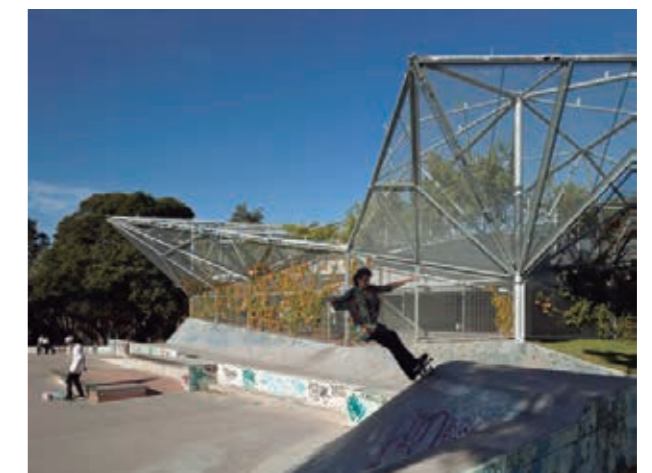
Tomado de (Plataforma Arquitectura, 2014)
