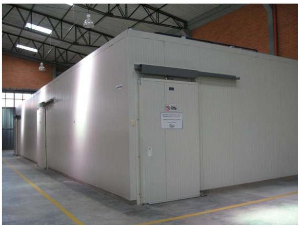
Cuarto de refrigeración 2.52mts x 2.52m. Conserva temperaturas a -10 grados centígrados puertas en acero inoxidable, con herrajes especiales, paneles de las cámaras aislados con poliuretano inyectado con capacidad de 4 toneladas. Precio \$22 500.
