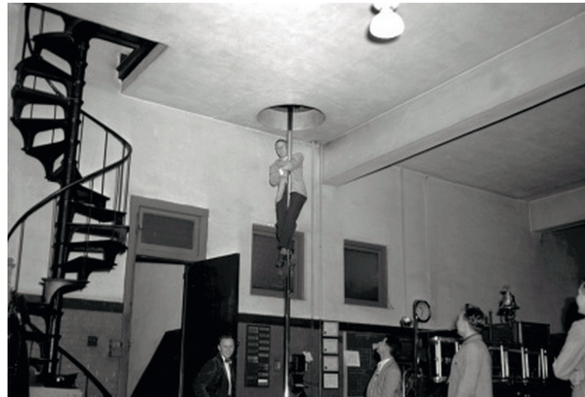
Figura 93. Tubo de descenso de bomberos.
