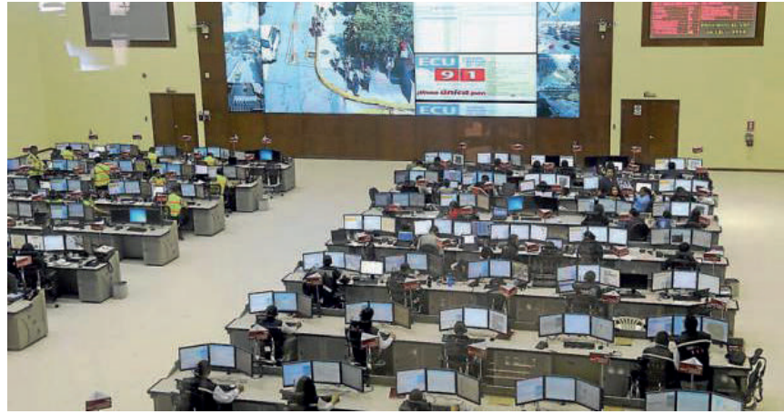
Figura 92. Sala de ECU911
