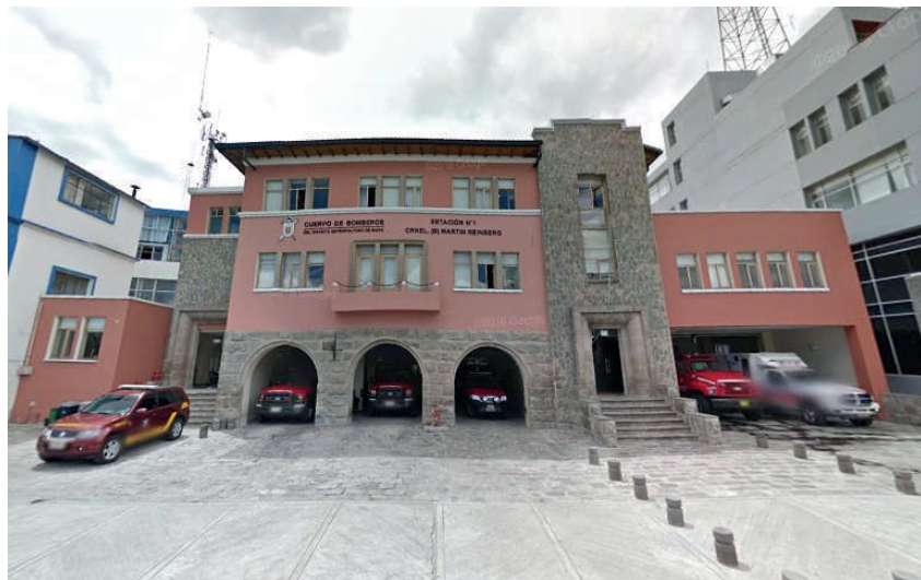
Figura 25. Estación de bomberos #1 La Mariscal.
