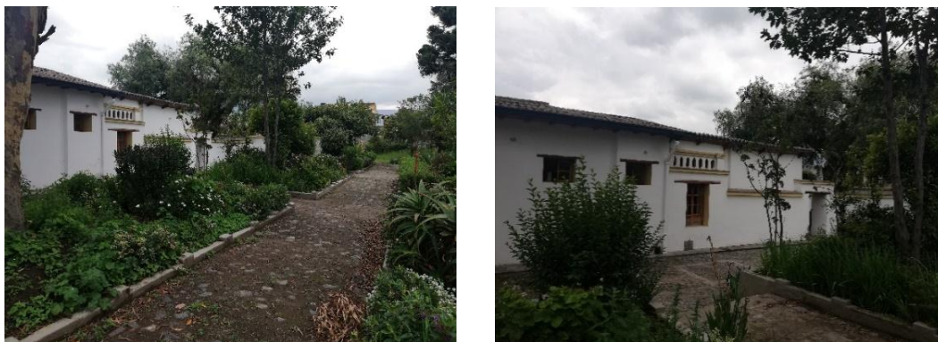
Figura 42. Patios y vegetación de la Edificación a intervenir
