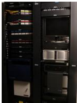
Figura 56. Instalación necesaria para internet Tomado de (audiovisión, 2010)
