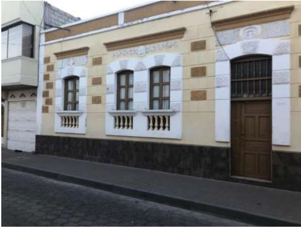
Figura 8- Fachada del sitio
