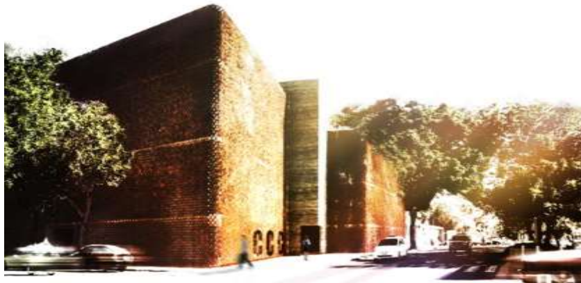
Figura 26- Fachada de Centro Guadalajara
