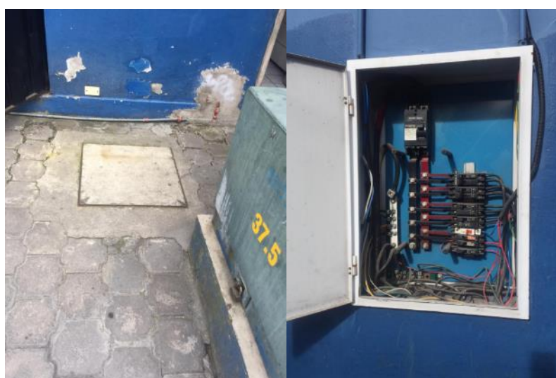
Figura 113 y 114. Instalación sanitaria- eléctrica
