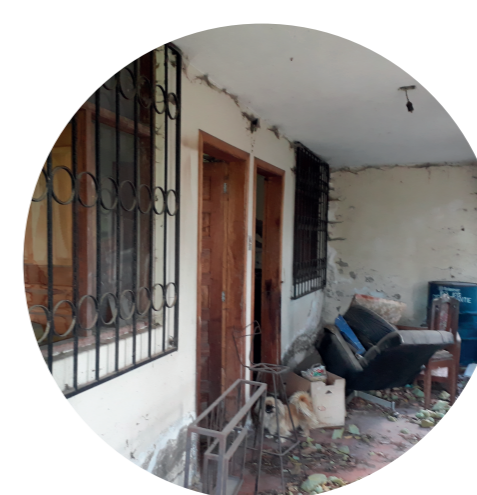
CORREDOR PLANTA SUBSUELO
