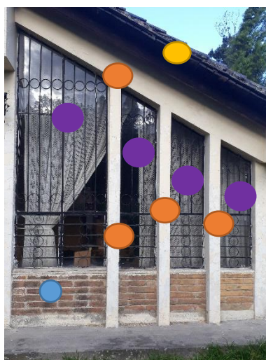
Figura 102. Fachada Ingreso Principal
