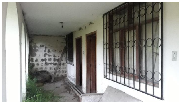
Figura 10. Corredor parte baja de la Casa
