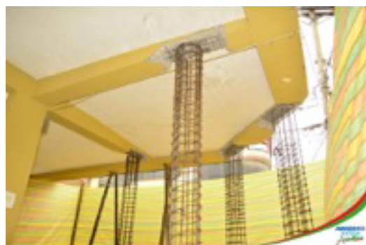
Figura17. Anclaje de la nueva estructura a las vigas con las que ya contaba el municipio para reforzar la antigua estructura. Palacio Municipal (GADA, 2010)
