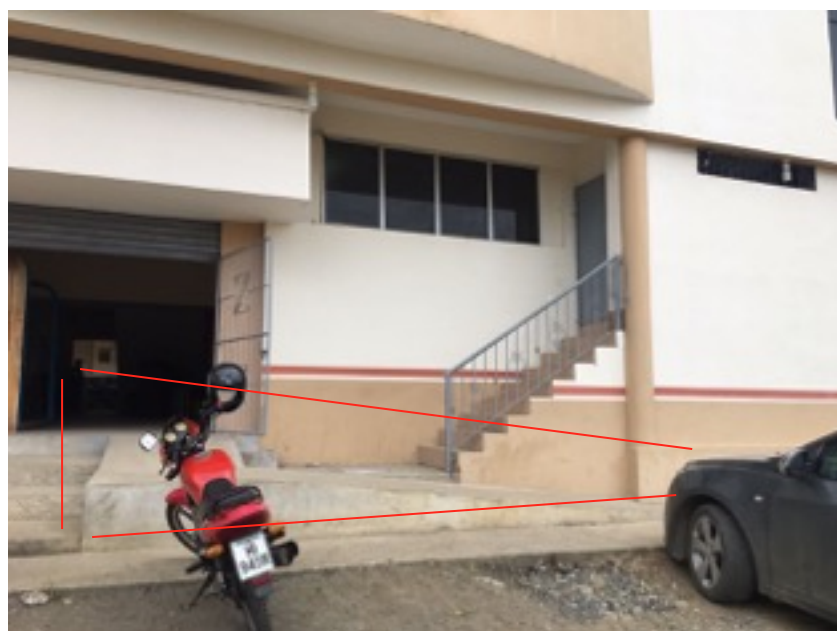
Figura 64. Rampa fachada posterior.
