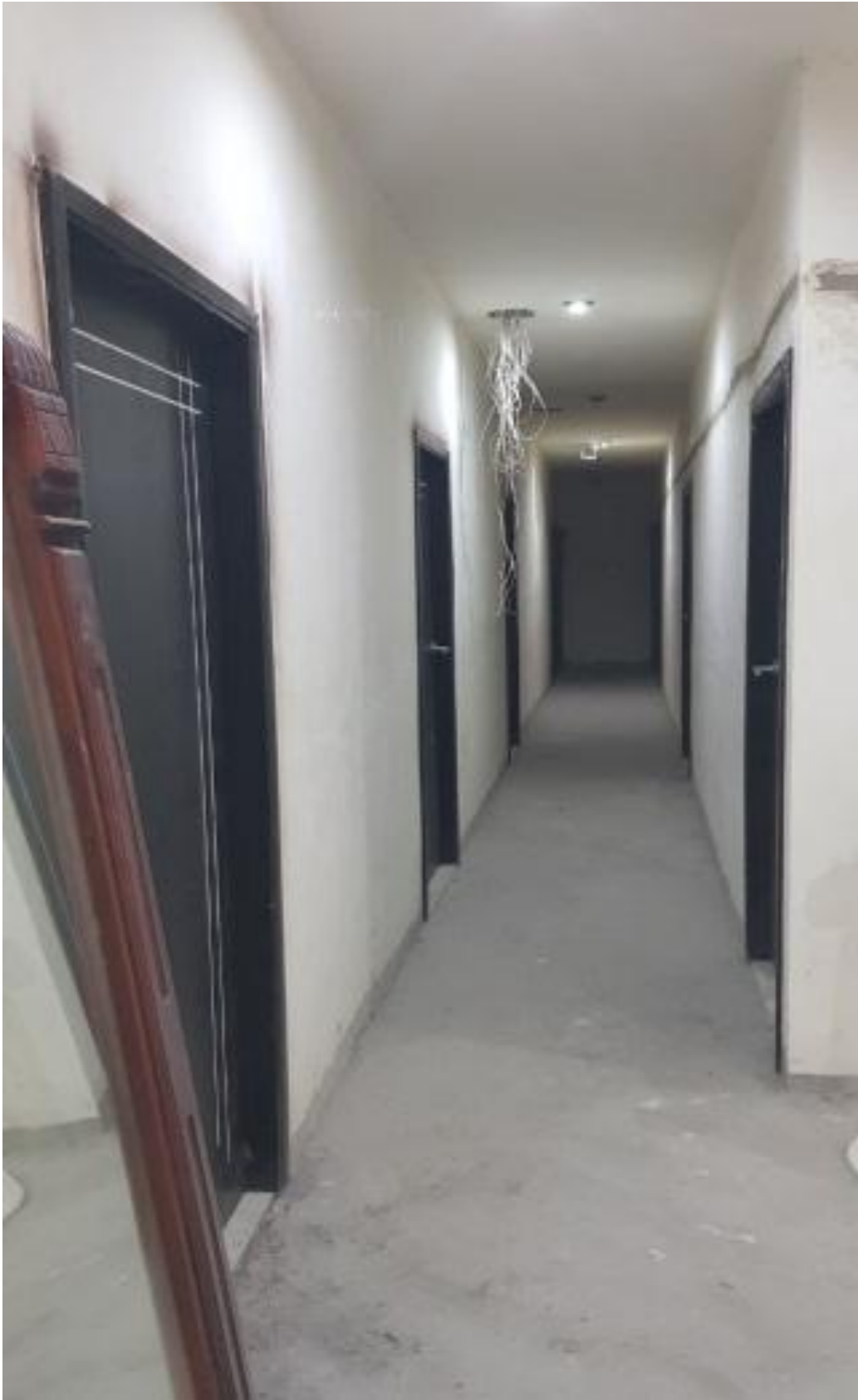
Figura 41. Pasillo tercer piso Hotel King David.
