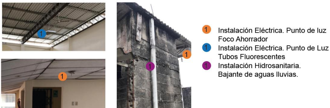
Figura 122. Interior de la edificación instalaciones
