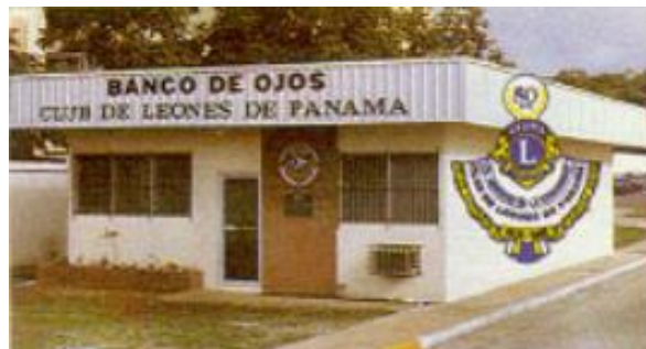
Figura 11. Construcción de Banco de Ojos, Panamá Tomado de: Wong, 1947
