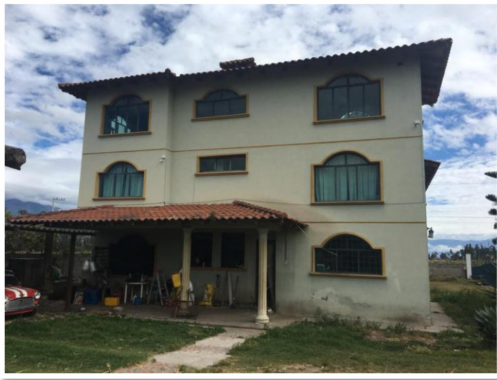
Figura 5. Vista exterior ingreso secundario
