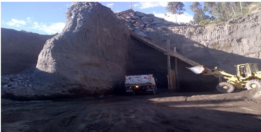
Figura 7. Vista Lateral de Zarandas para el Cribado Artesanal de Material.
