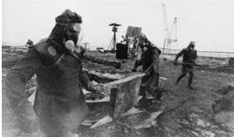
Figura 8. Liquidadores en el techo. Tomado de (desastrenuclear, 2012).
