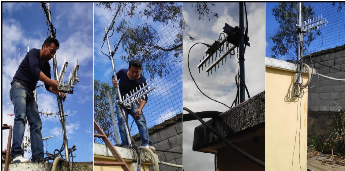
Figura 62. Instalación de la antena.
