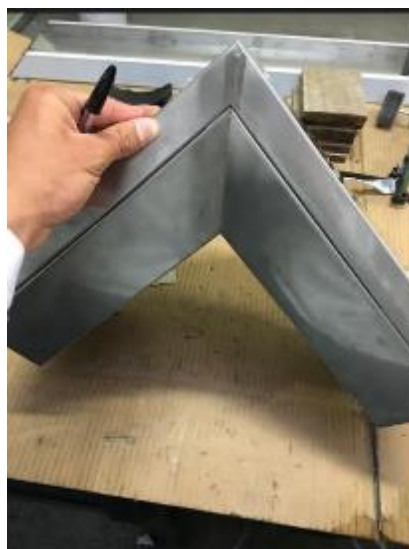
Figura 37. Acabado de la parte inferior del marco del techo
