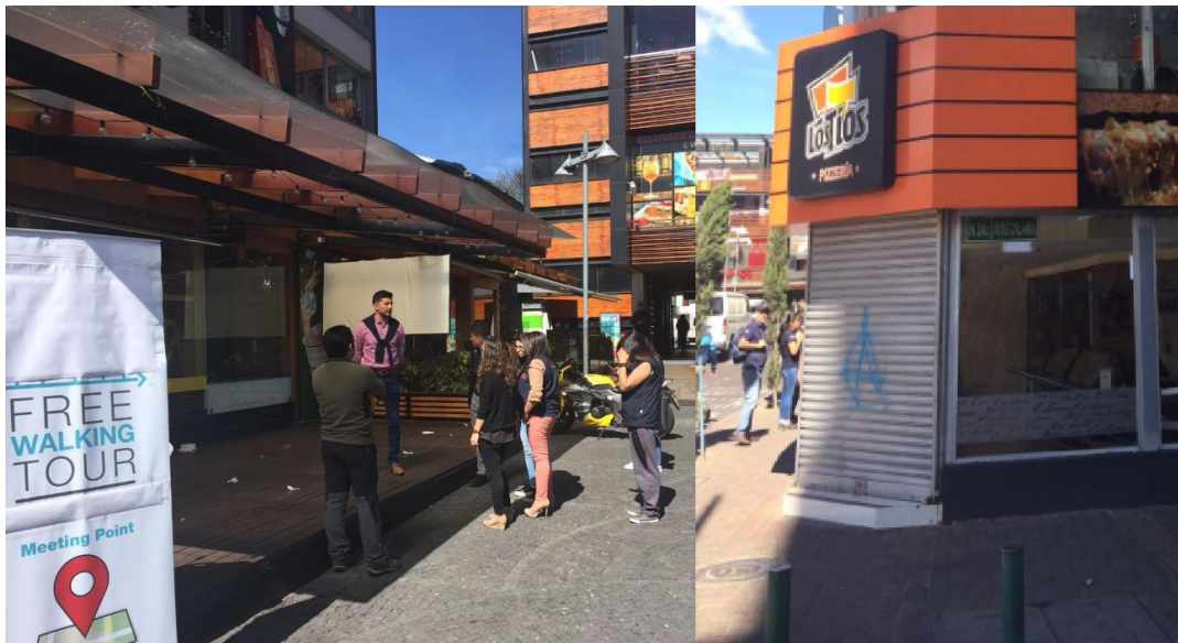
Figura No 12: Establecimientos sin rampas de acceso.
