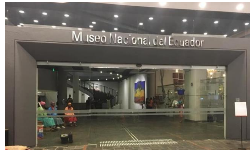
Figura 2: Podotácil instalado en la entrada del Museo Nacional.
