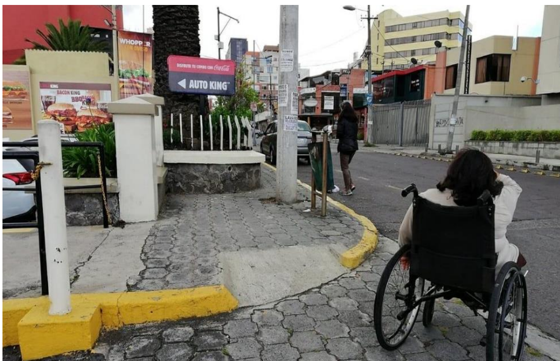
Figura No 2: De nada sirve un vado si la acera es inaccesible (av. Reina victoria y Francisco de Orellana).
